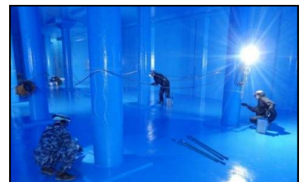
防食工事（上下水道） 防食塗膜上塗り
