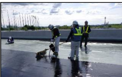
橋面防水工事 アスファルト塗膜材塗布
