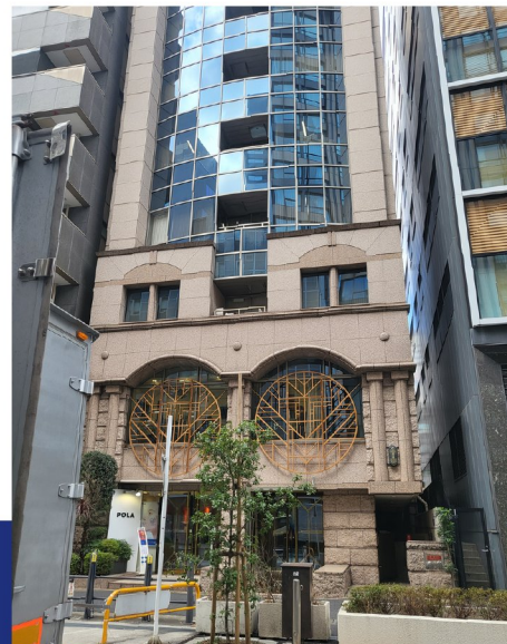
外壁修繕工事を手掛けたビル
